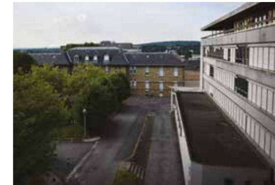
Le bâtiment Émile Lannois.
