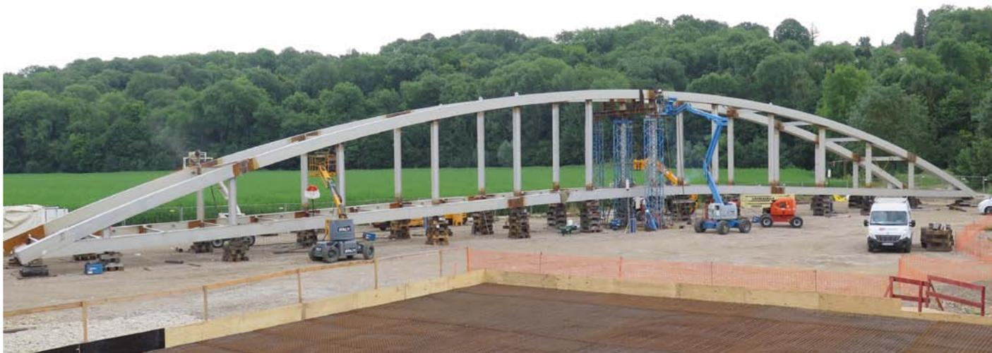
La passerelle de 130 tonnes est en cours d'assemblage sur la rive et sera posée sur ses piles le 25 juillet.
