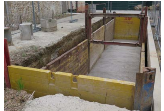
Creuser une grande fosse
