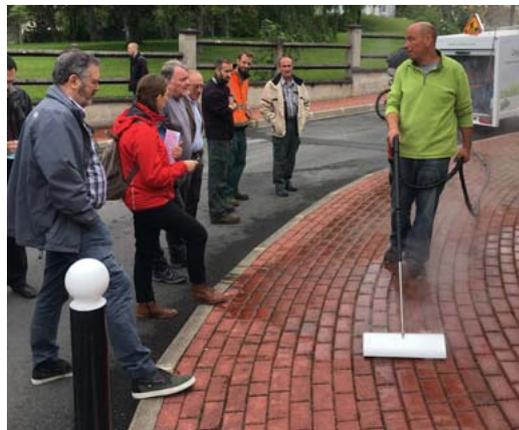
Traitement par eau chaude des indésirables dans les joints de pavés.
