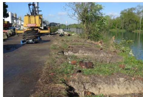
Fondations du prochain ponton de détente sur la Marne
