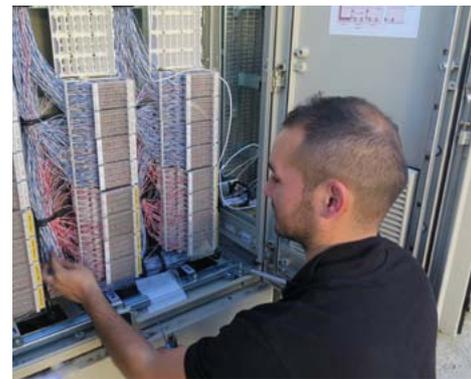
La montée en débit des communes les plus carencées de Marne et Gondoire est en voie d'achèvement. Pour l'abonné, l'opération est transparente et se traduit par un débit amélioré de sa connexion ADSL. Ci-dessus, branchement des lignes téléphoniques des abonnés à l'armoire de montée en débit numérique de Chanteloup le 16 mars.
