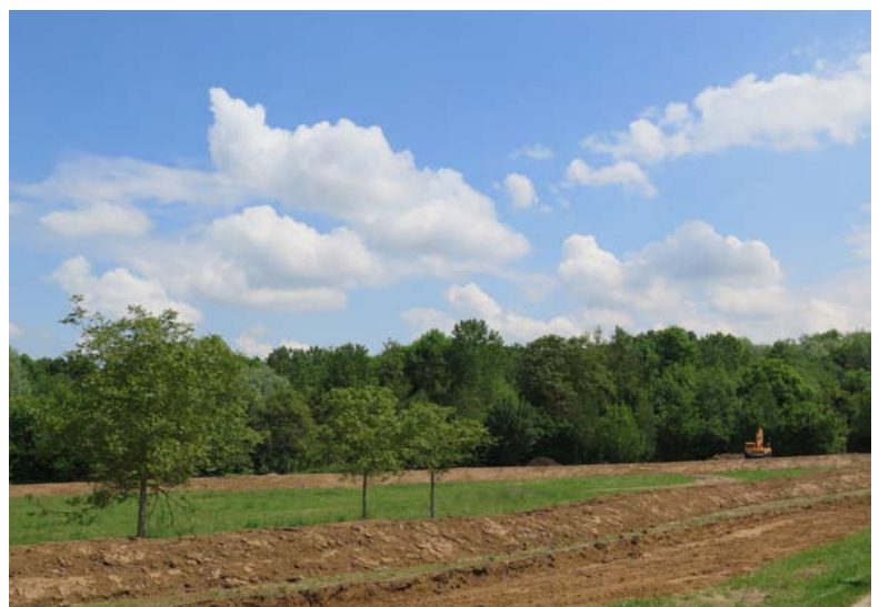
Le merlon en cours d'aménagement vendredi
