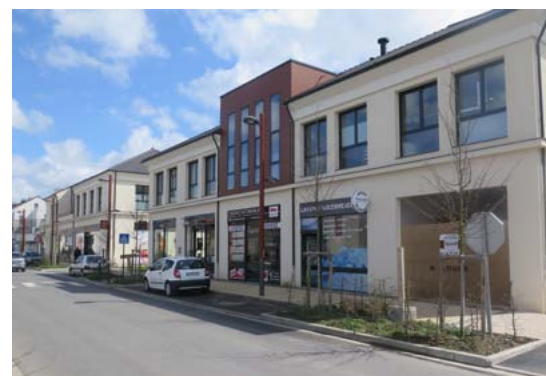
Commerces de proximité et bureaux pour la seconde phase
