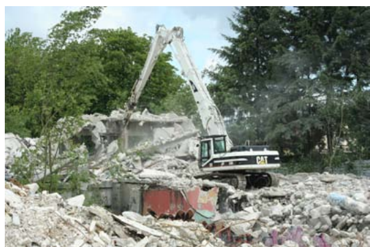
Engin équipé d'une pince pour «grignoter» des bâtiments dans le site classé de Rentilly en 2006
