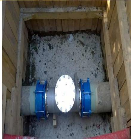
La gaine est intégré dans le réseau (photo1) – les coudes ont été remplacés (photo 2)- chambre d'accès (photo3).
