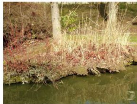
Berge de type 3 – Naturelle avec un léger affouillement
