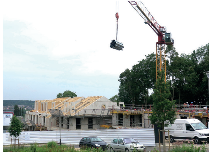
Construction d'un collectif de 29 logements ZAC des Cordonniers (Dampmart)
