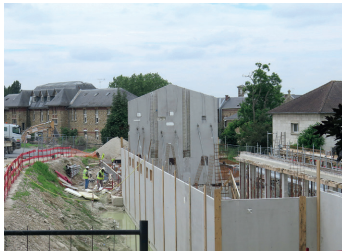
La maison de santé de Marne et Gondoire en construction (site Saint-Jean Lagny)
