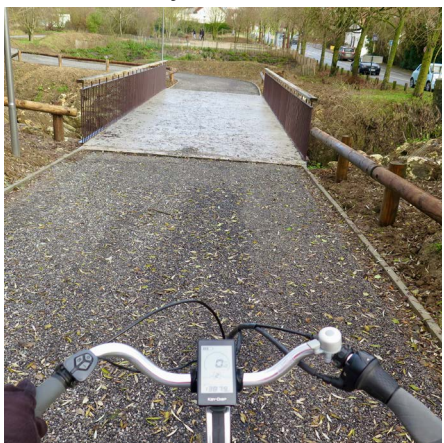
À Bussy. De l'autre côté du pont sur la Gondoire, Chanteloup (section non finalisée)
