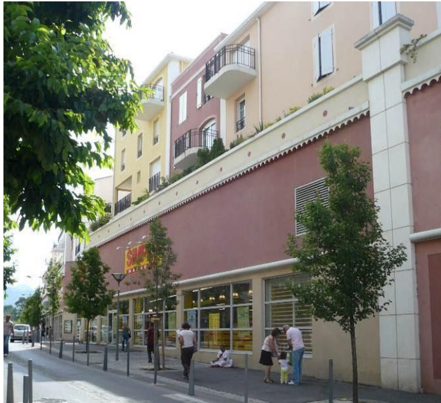
Commerces de centre ville à Aubagne (Citadia)
