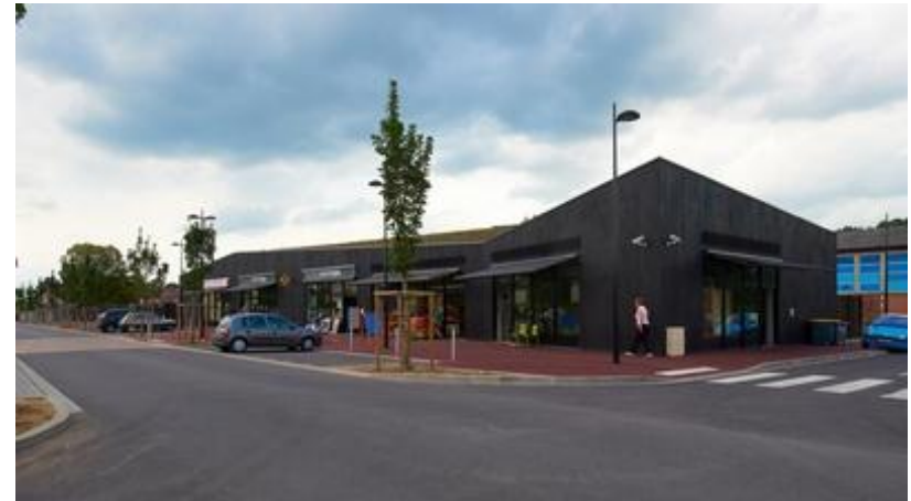
Commerce intermédiaire intégré situé dans la commune d'Hauumont (59)
