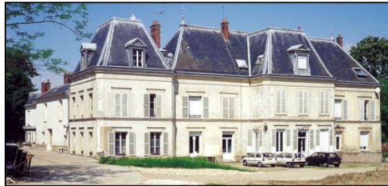
Centre d'aide par le travail La Grange aux Bois, Lagny-sur-Marne.
