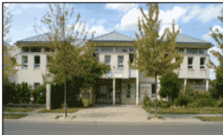
Le Bleu du ciel, structure multi-accueil, Bussy-Saint-Georges
