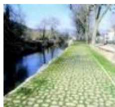
Exemple de recouvrement poreux : le pavé à joints ouverts
