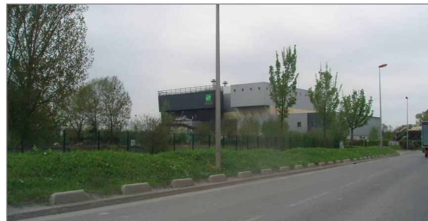
Usine d'Incinération d'Ordures Ménagères du SIETREM à Saint-Thibault-des-Vignes
