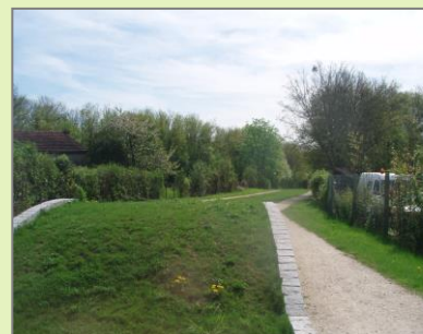
Promenade piétonne sur l'aqueduc de la Dhuis
