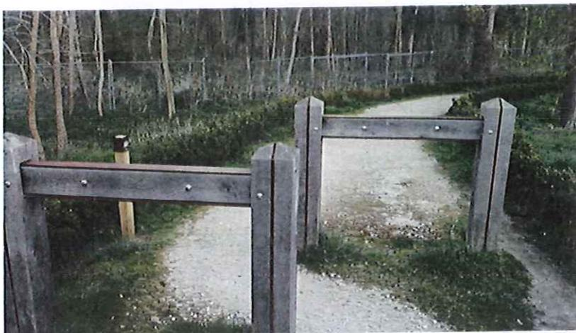
Ce type de dispositif de contrôle d'accès en bois renforcé par un IPN acier est déjà utilisé sur la voirie communautaire. En effet, la CAMG gère plus de 90 km de chemins communautaires. Ces derniers sont équipés de divers dispositifs de contrôles d'accès comme ces bornes, ou encore des potelets, portiques, barrières coulissantes ou chicanes, dont le choix se fait selon les usages et les contextes.
