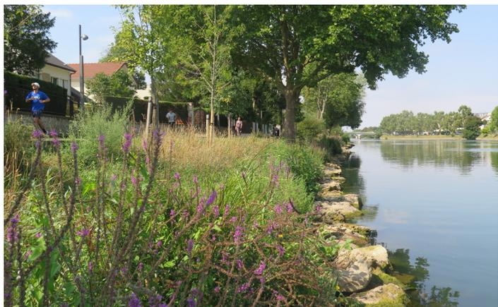
À Lagny, du port de plaisance au centre-ville, le béton ferrillé cède la place à la végétation pour tenir les talus et aux pierres de calcaire dur pour protéger les pieds de berges.
