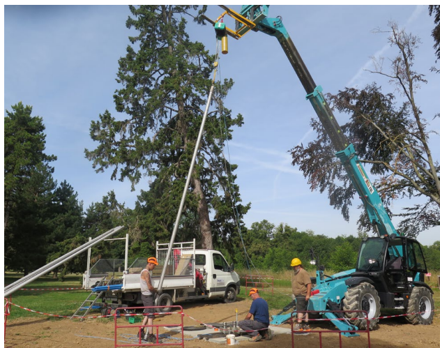
Pose de la canalisation de rejet début juillet par sections jointes entre elles.
