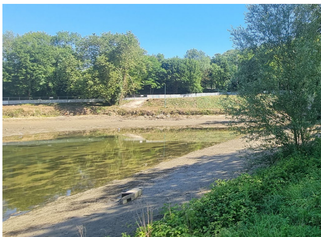
Le même bassin, maintenant vidé pour préparer les travaux du tunnel
