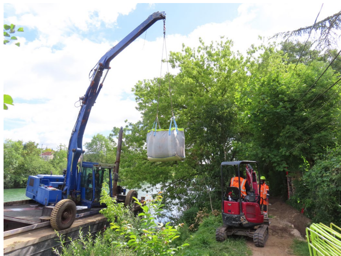
Enfouissement de réseaux
