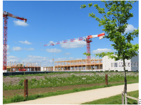
Le lycée en construction
