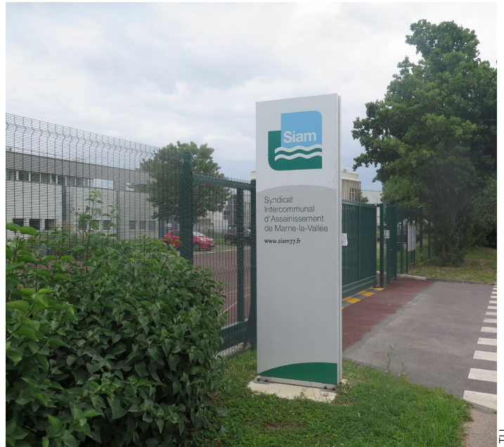
L'usine d'épuration de Saint-Thibault-des-Vignes, siège du SIAM
