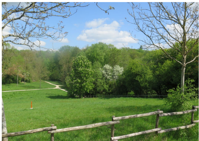
Le talus du barrage côté versant : un dénivelé de 10 mètres !
