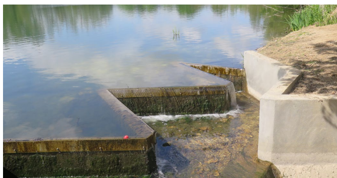
Le seuil en zebra de l'exutoire avec la nouvelle maçonnerie à droite
