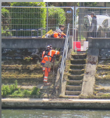
Dépose des garde-corps
