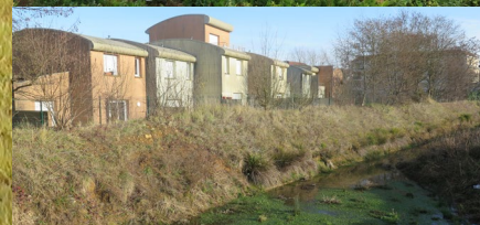
Recueil des eaux pluviales de l'éco-quartier des Roseaux dans de larges noues
