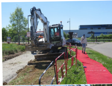
Tapis rouge pour les piétons pendant les travaux !
