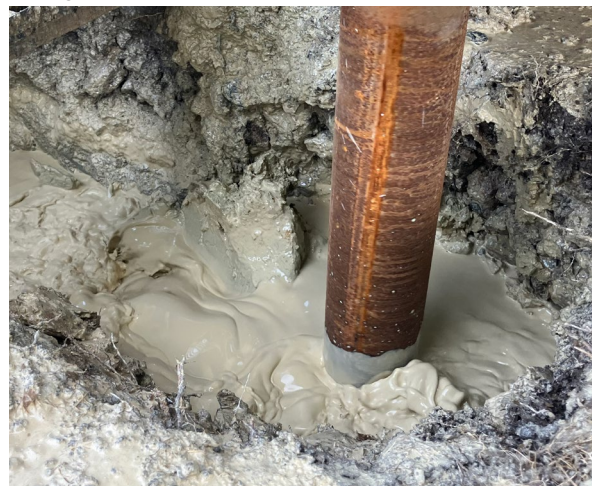
L'adjonction de boue facilite le forage.
