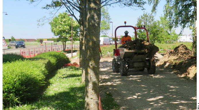
Le long de la D35 à l'entrée de Ferrières-en-Brie
