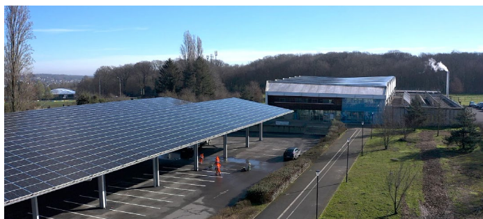
À Lagny, le centre aquatique comprend déjà 2000 m 2 d'ombrières photovoltaïques qui couvrent le parking depuis septembre 2024 et produisent 480 MWh par an qui alimentent le réseau public de distribution d'électricité.
