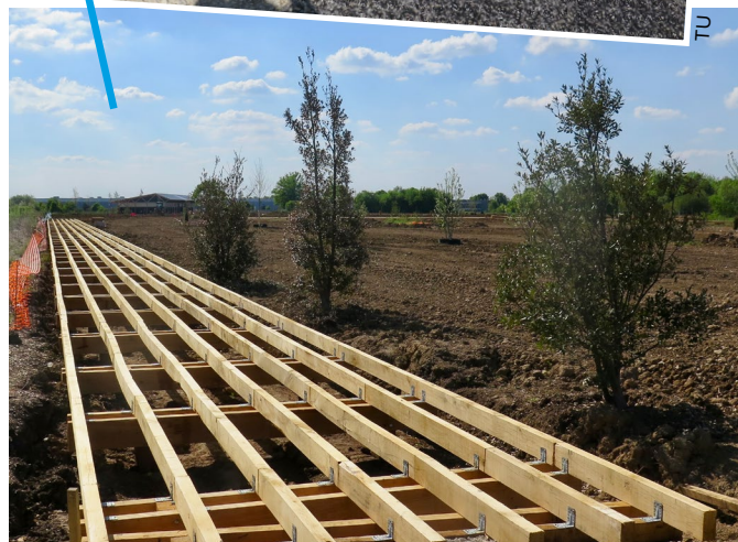
Ce platelage en bois permettra de traverser la partie humide en gardant les pieds secs.
