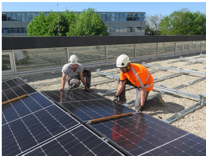
Sur le toit du centre aquatique à Lagny-sur-Marne
