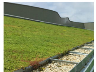
Toiture végétalisée de la Maison de la nature à Ferrières-en-Brie
