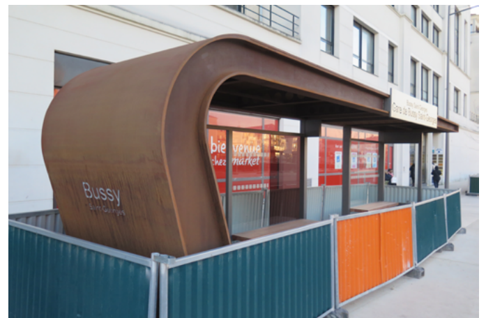
Acier à corrosion forcée, le corten confère résistance accrue et aspect contemporain aux ouvrages métalliques.
