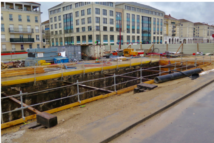
Les souterrains d'accès en cours de creusement, janvier 2018
