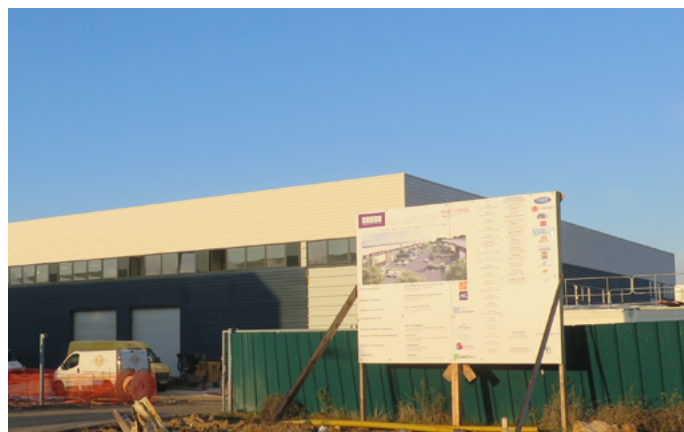
Le parc PME / PMI Innovespace en construction à Chanteloup-en-Brie. Ouverture en 2019.
