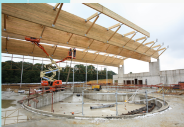
Juillet 2007 : les travaux sont en cours
