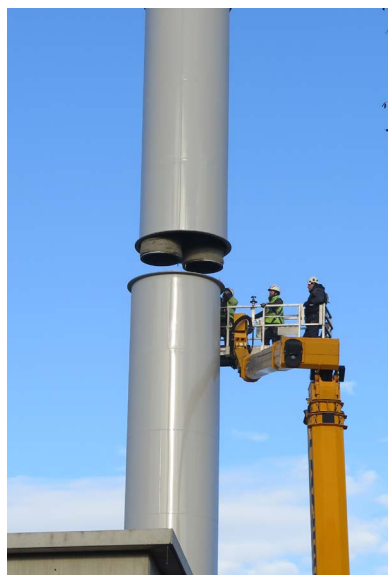
La pose de la cheminée de la chaufferie. 12 tonnes et 30 mètres de haut. Rassurez les enfants, le père Noël ne compte pas y descendre.
