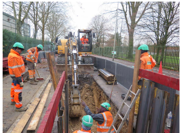
Plusieurs entreprises de travaux publics travaillent simultanément sur les différents points du chantier. Ici, TPSM, une société Seine-et-Marnaise.
