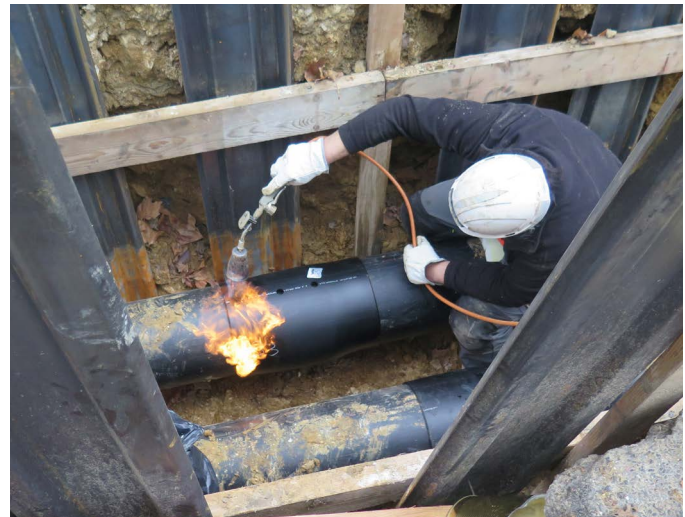
Un manchon souple est ensuite thermocollé à la flamme pour protéger la soudure.
