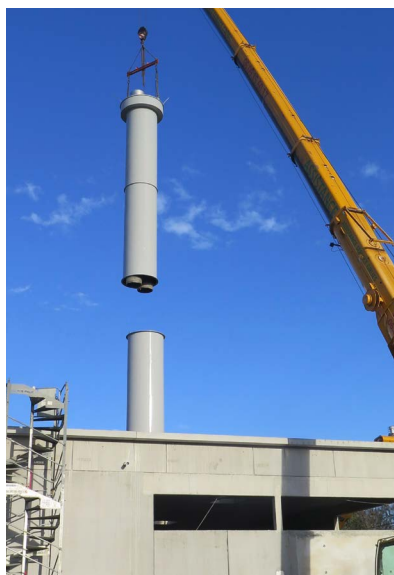
La pose de la cheminée de la chaufferie. 12 tonnes et 30 mètres de haut. Rassurez les enfants, le père Noël ne compte pas y descendre.
