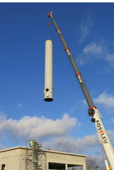
La pose de la cheminée de la chaufferie. 12 tonnes et 30 mètres de haut. Rassurez les enfants, le père Noël ne compte pas y descendre.
