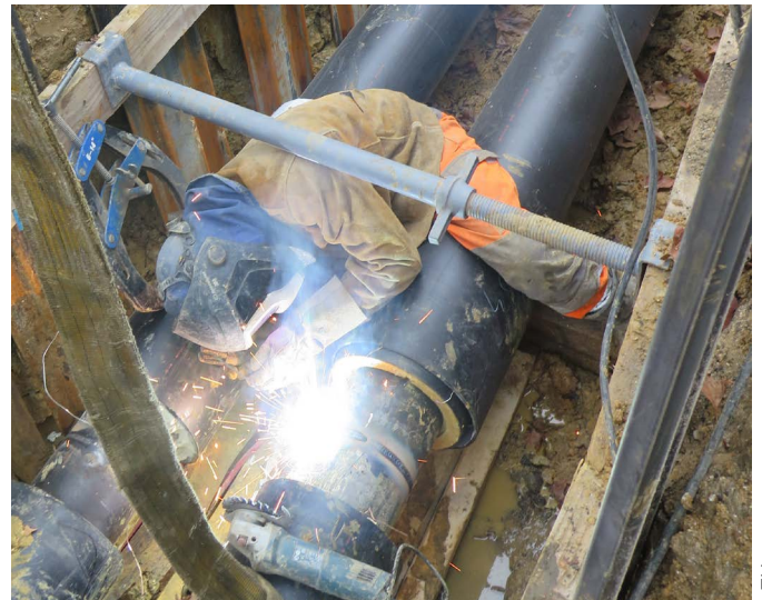
Les canalisations livrées en barres de 12 mètres sont soudées dans la tranchée par des professionnels chevronnés.
