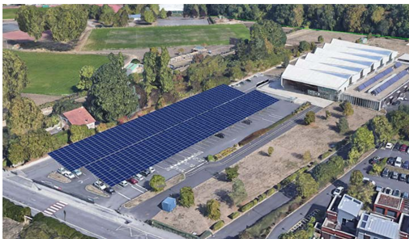
Vue des deux ombrières une fois réalisées. Au fond, le centre aquatique.
