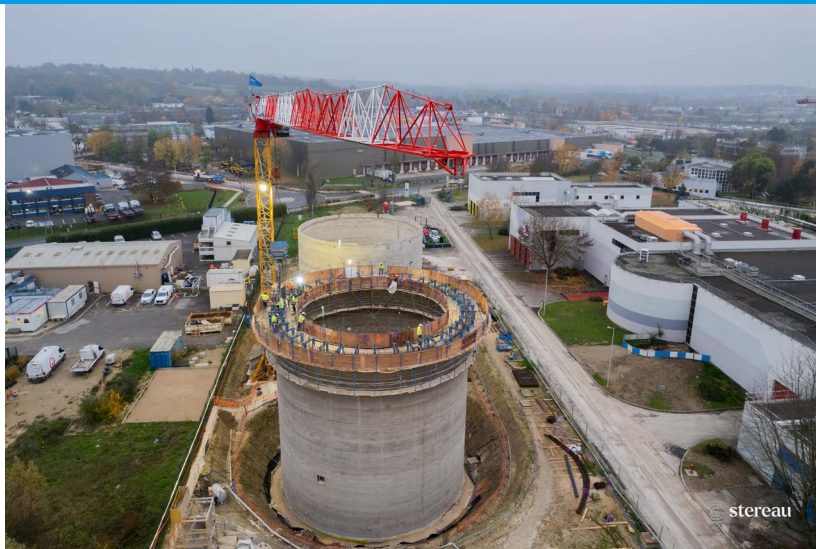
L'unité de méthanisation du SIAM en cours de construction à Saint-Thibault
