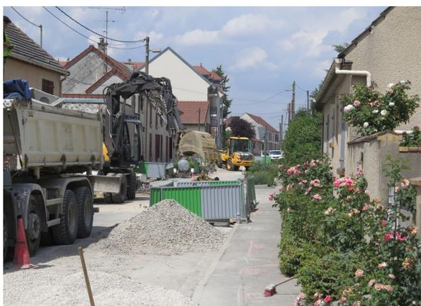
Marne et Gondoire fait réaliser actuellement des travaux de mise en conformité des réseaux d'assainissement et renouvellement de la canalisation d'eau potable avenue de la Jonchère à Chanteloup-en-Brie.
