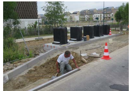
Installer les pave, procéder aux aménagements de voirie nécessaires
