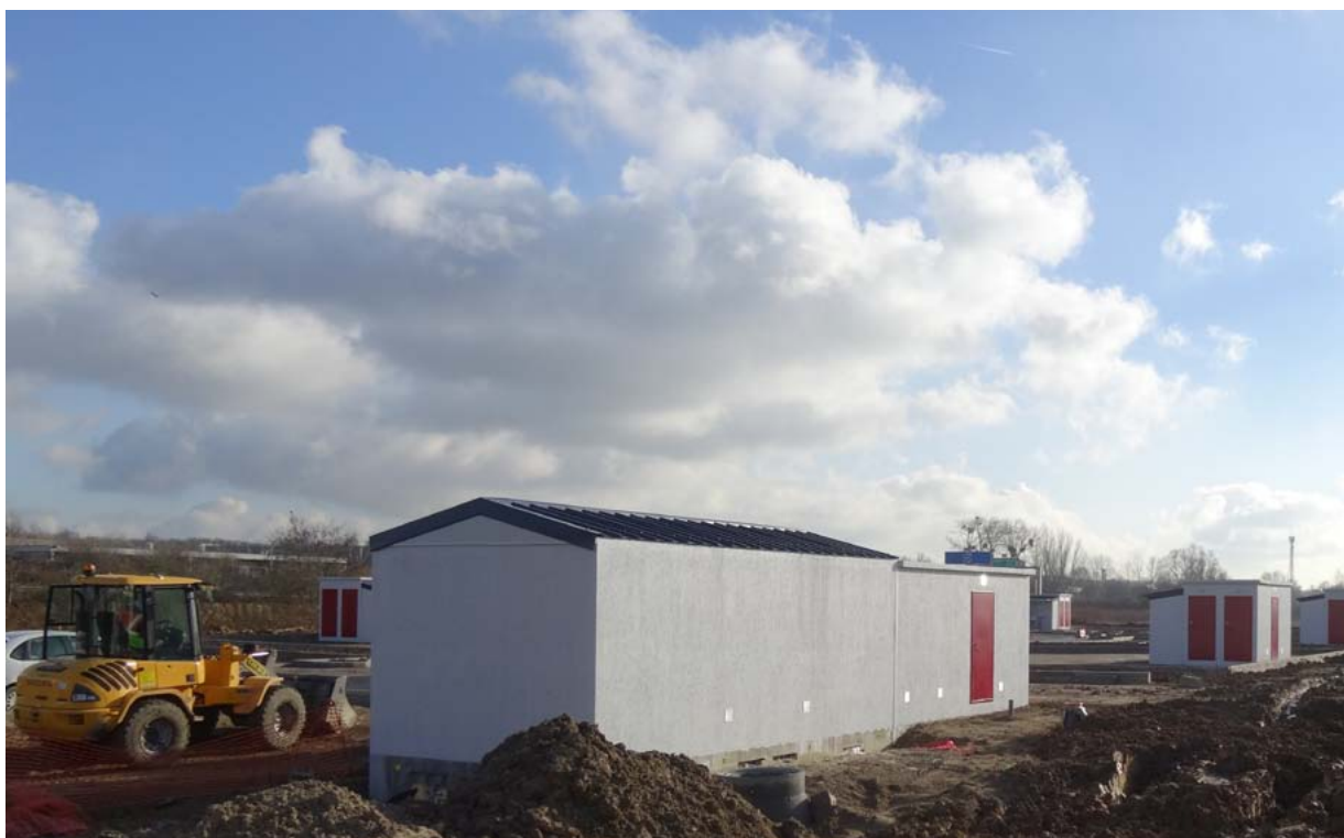
Aire d'accueil de Saint-Thibault en construction (décembre 2014)
