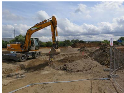
Travaux de terrassement, août 2014
