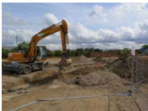
Travaux de terrassement, août 2014
