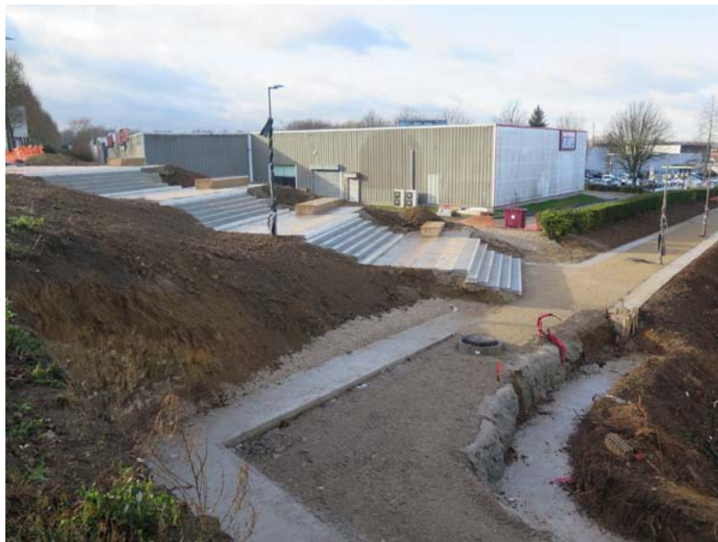
Le nouvel accès piétons depuis la départementale en face du centre culturel de Saint-Thibault est en cours de réalisation.
