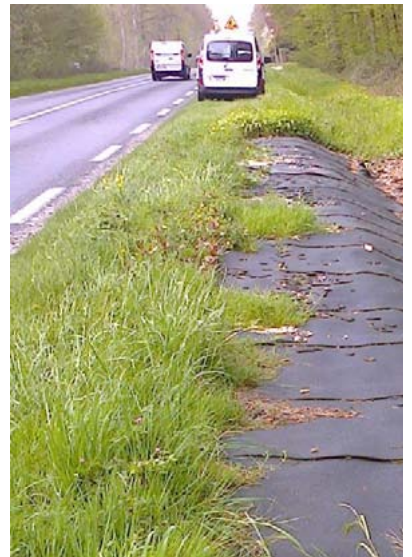
Des bâches «anti-renouées» le long des routes
