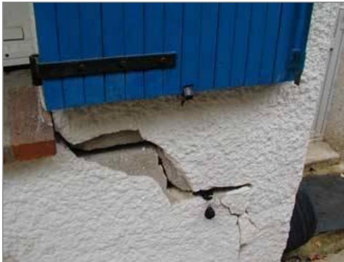
Exemple de dégâts causés par le retrait ou le gonflement des argiles (source : BRGM)
