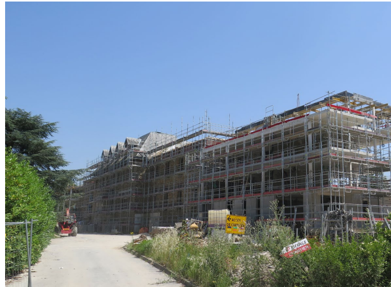
La reconversion du bâtiment Colonel Durand en 34 logements sociaux par Emmaüs habitat
